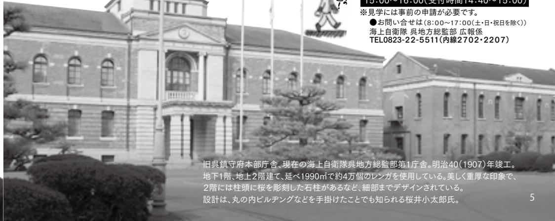
旧呉鎮守府本部庁舎。現在の海上自衛隊呉地方総監部第1庁舎。明治40(1907)年竣工。地下1階・地上2階建て、延べ1990㎡で約4万個のレンガを使用している。美しく重厚な印象で、2階には柱頭に桜を彫刻した石柱があるなど、細部までデザインされている。設計は、丸の内ビルディングなどを手掛けたことも知られる桜井小太郎氏。
