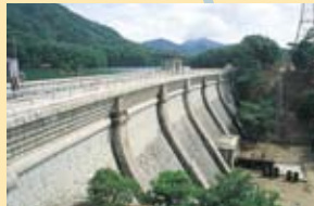
本庄水源地堰堤 (国重要文化財)
