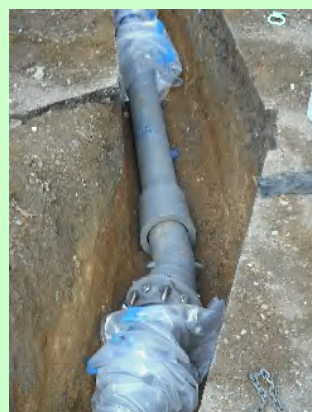
GX型ダクタイル鋳鉄管 (ポリエチレンスリーブ被覆前)
