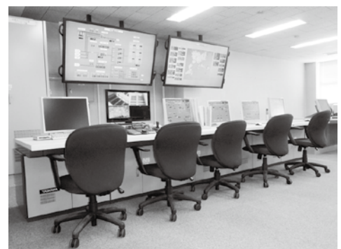
宮原浄水場中央監視装置
