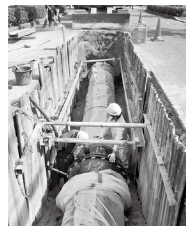
配水管布設工事現場（耐震管）
