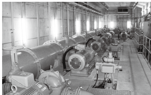
宮原浄水場ポンプ室
