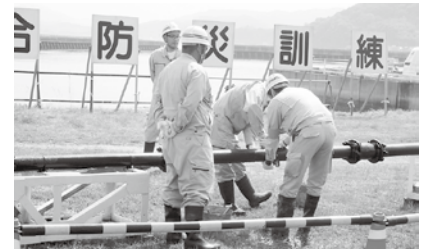
呉市総合防災訓練 漏水修繕の様子
