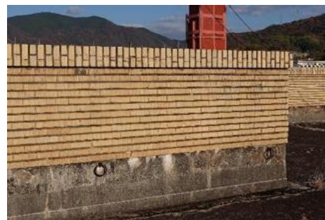
屋上スクラッチタイル
