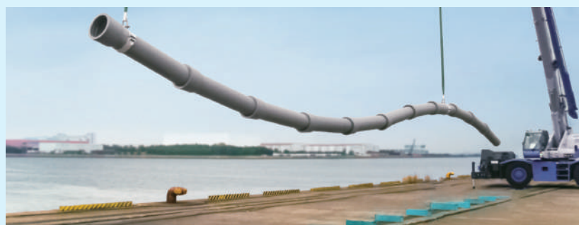
耐震管の継ぎ手が抜けないことを実証するクレーンつり上げ実験の様子
