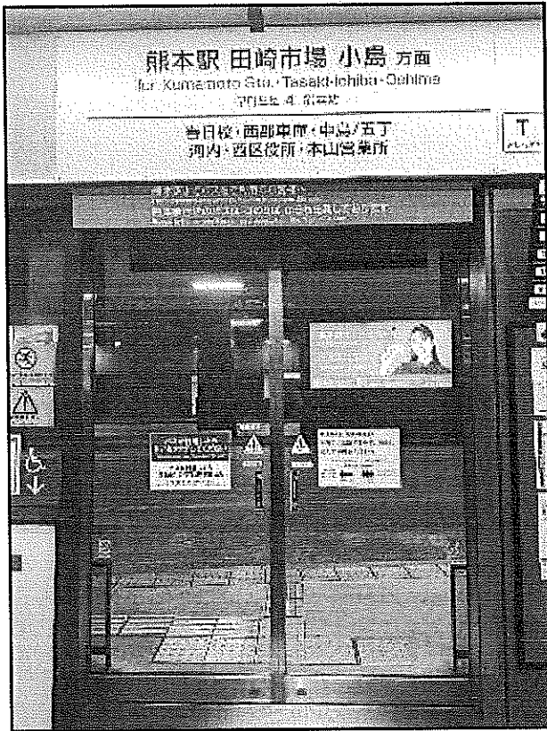
↑ホームドアの設置 待機場所が外気から守られている
