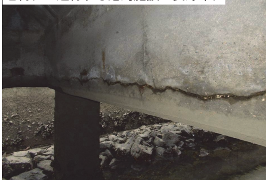
川原石地区 川原石臨港道路 平成28年～
