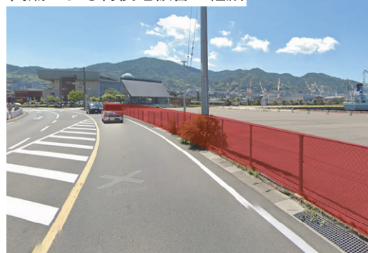
宝町地区 胸壁・陸閘整備 令和5年～
