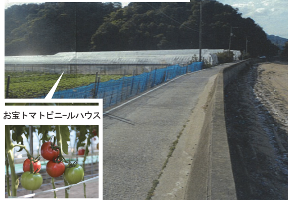
農地海岸 倉橋町本倉井地区 平成29年着手
