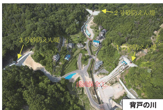
3つの砂防えん堤完成 溪流保全工施工中
