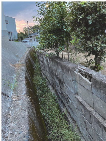
安全対策強化事業 （ブロック塀の改修）
