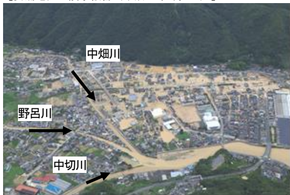
【安浦地区の浸水被害（平成30年7月7日）】
