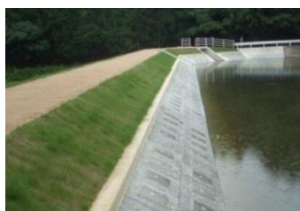
【写真1】補強工事（改修）
