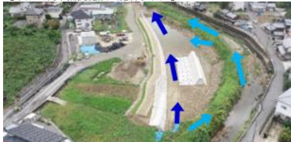
【中畑川流木捕捉施設（施行状況）】
