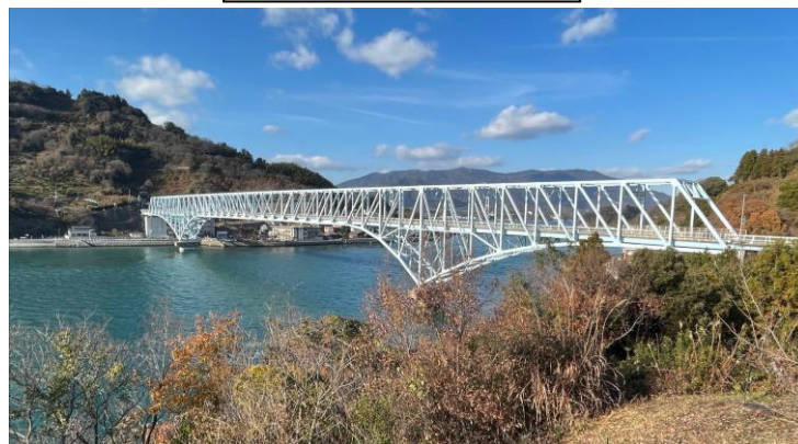
上部工耐震補強
