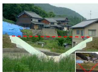
【写真2】廃止工事（開削）
