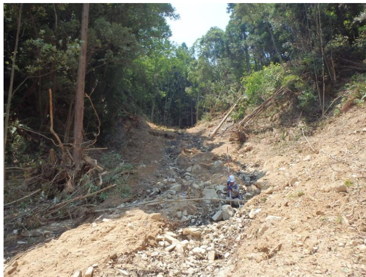
〔安浦町光木5〕 治山ダム施行計画地状況
