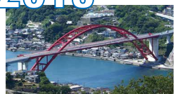
第二音戸大橋
