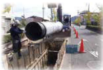
水道管の更新工事の様子
