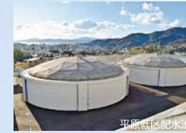
平原地区配水池
