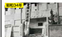
水道局庁舎正面
