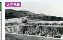
平原浄水場低区配水池築造工事
