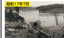
三永水源地導水管布設工事
