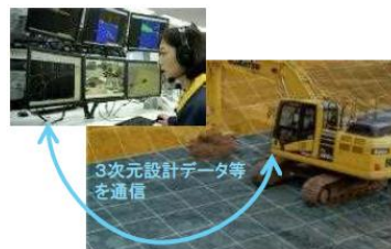
【ICT建設機械による自動施工】
