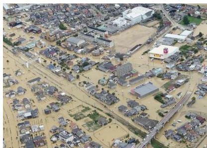
【平成 30 年 7 月豪雨で浸水した安浦町中心部】
