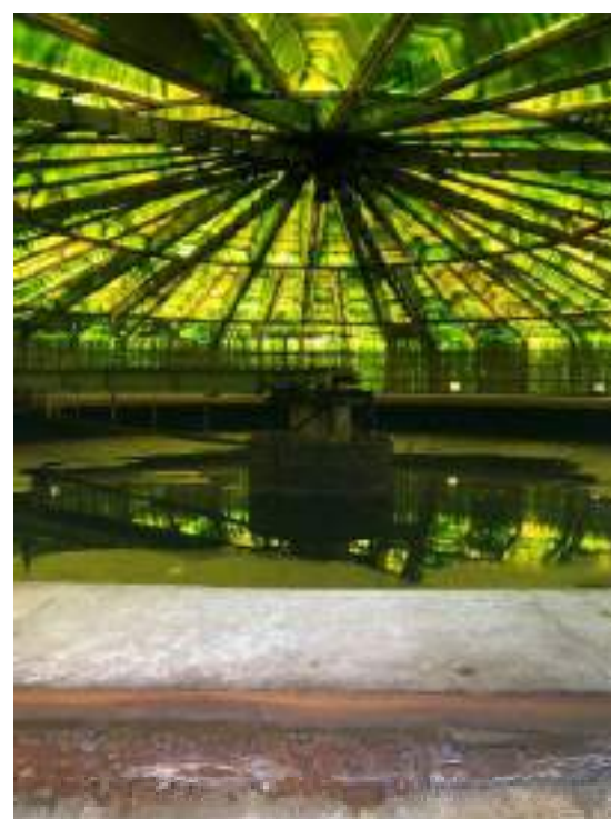
[最初沈殿池内部]
