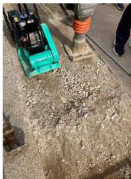
[埋設後の状況]
