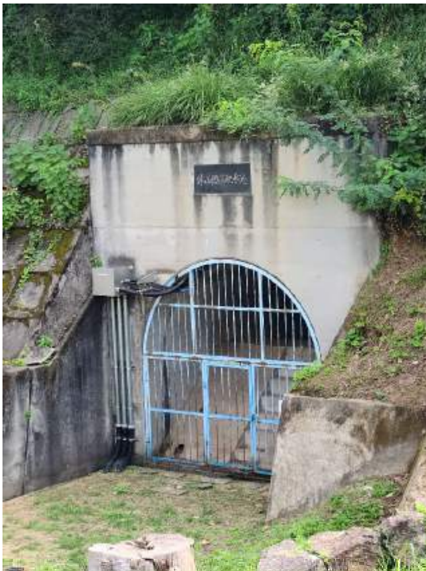
(休山隧道配水池)
