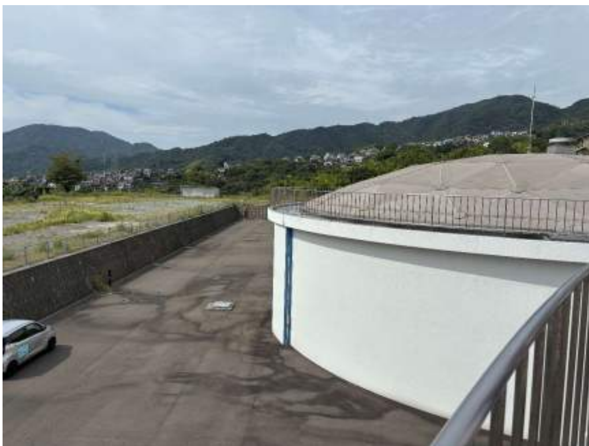
(平原低区配水池)
