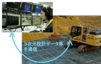
【ICT建設機械による自動施工】
