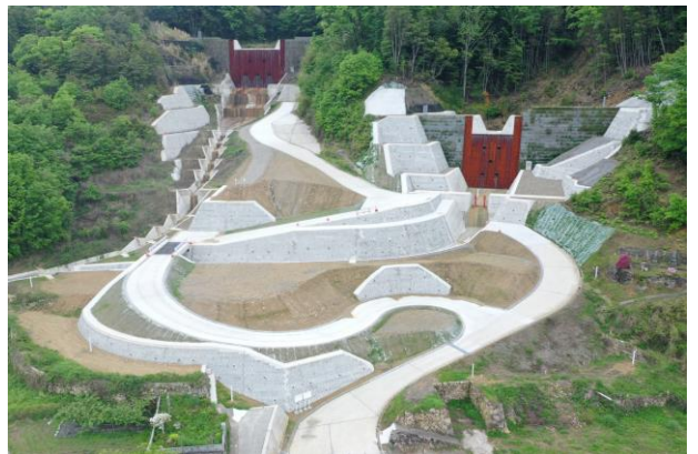
【平成30年7月豪雨で被災した 安浦町中畑地区における砂防えん堤の整備】
