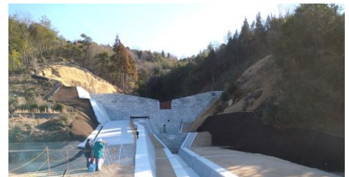
【国直轄砂防事業 背戸の川砂防施設（天応地区）】
