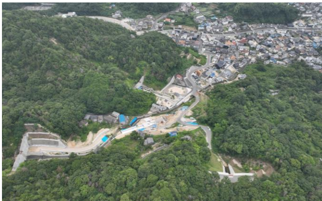
【平成30年7月豪雨で被災した 天応地区における砂防えん堤の整備】
