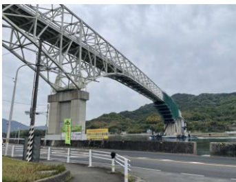
【早瀬大橋（国道487号）】
