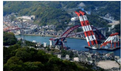
第二音戸大橋上部架設
