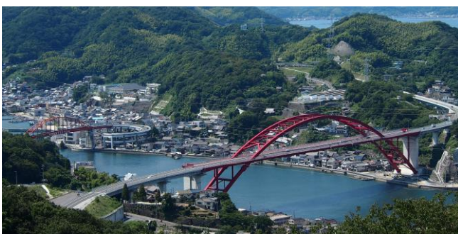
第二音戸大橋
