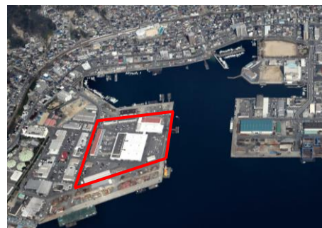
呉市地方卸売市場
