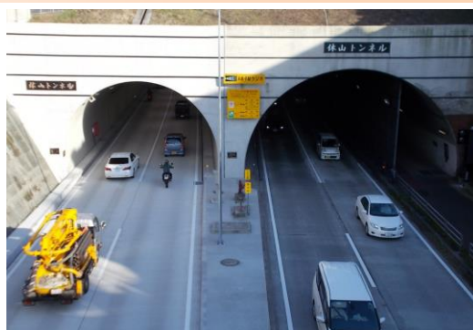
長迫側トンネル抗口
