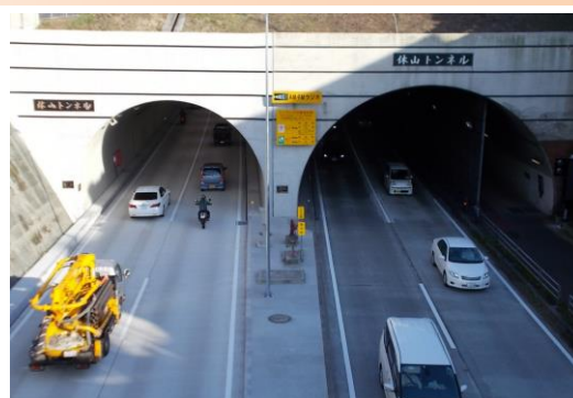
長迫側トンネル抗口
