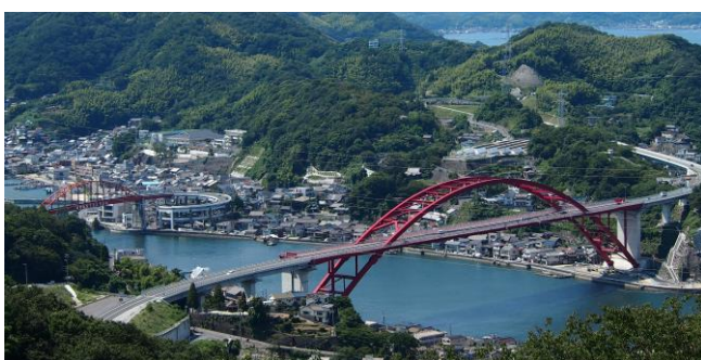
第二音戸大橋
