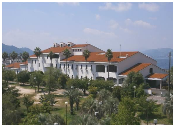
天応浄化センター
