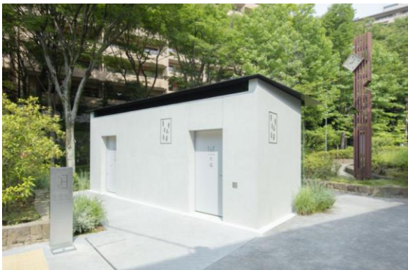
(出典) 広尾東公園トイレ 撮影：永禮賢 提供：渋谷区
