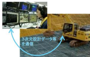
【ICT 建設機械による自動施工】
