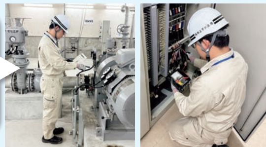
ポンプ所での点検作業(平原高区ポンプ所)
