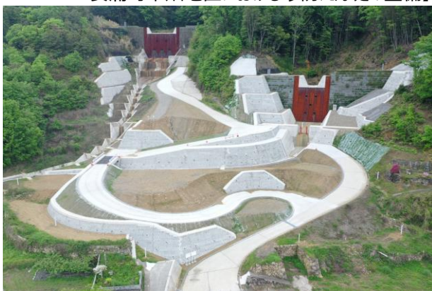
【平成30年7月豪雨で被災した 安浦町中畑地区における砂防えん堤の整備】
