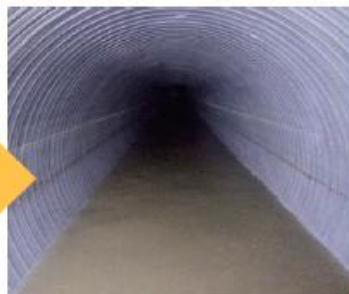
更生工事後の下水道管
