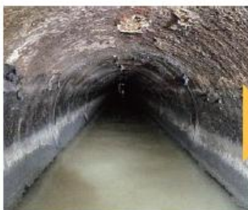
更生工事前の下水道管
