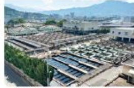
▲新宮浄化センター全景
