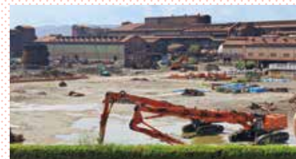
解体が進む日本製鉄呉地区
