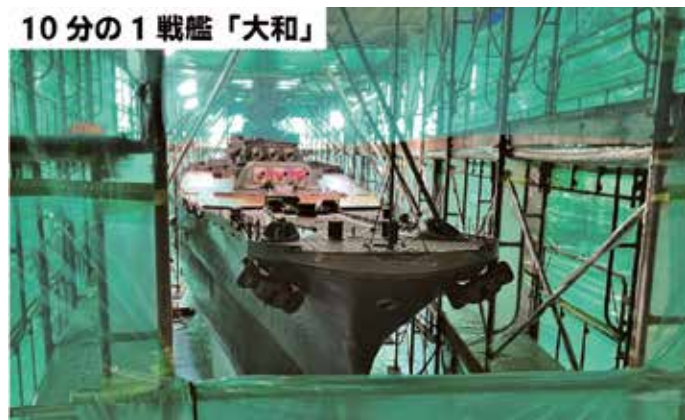
▲令和 8 年 4 月開館に向けてリニューアル工事中
