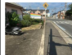
28-5:側溝に落下の危険性がある
