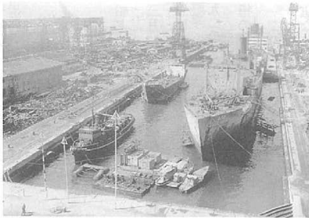
旧呉工廠第4ドック 昭和25年ころ撮影
