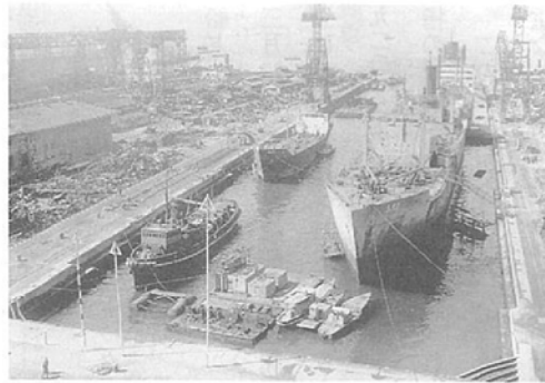
旧呉工廠第4ドック 昭和25年ころ撮影
