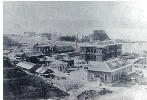
建設中の呉鎮守府庁舎(左奥)と海軍病院(手前)の 建物群(宮原村) 明治21年頃
