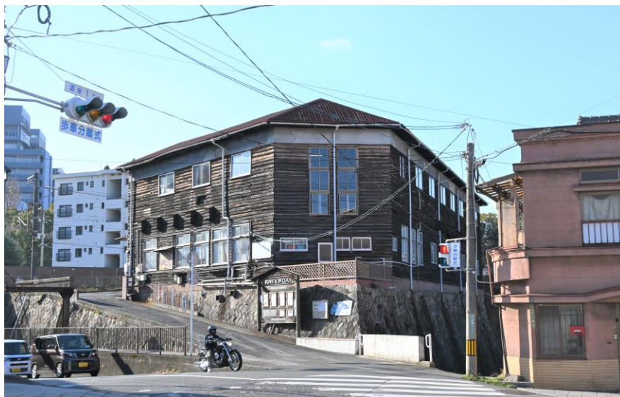
0 5 建物外観・遠景（北から）
