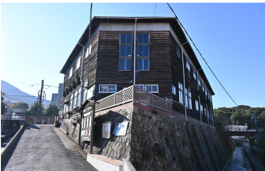
0 6 建物外観・北面（北から）
