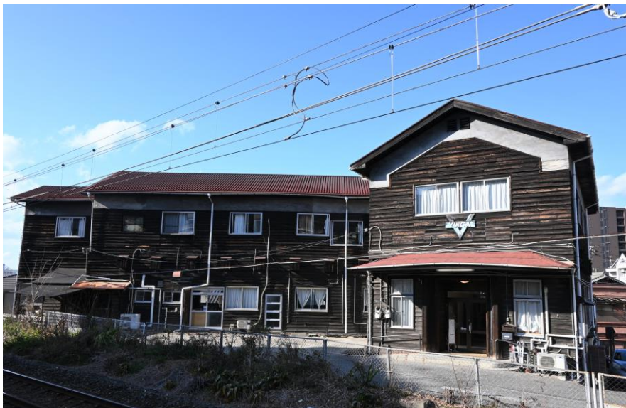
0 1 建物外観・南面（南南東から）
