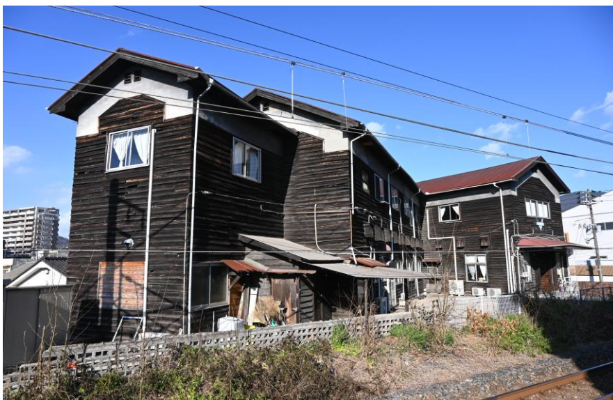
0 3 建物外観・南西面（南西から）
