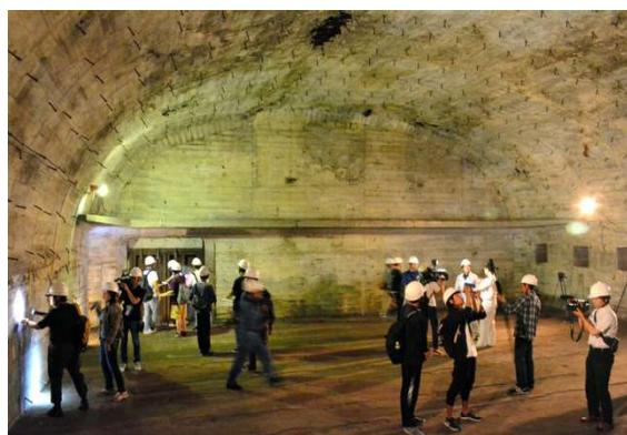
「旧呉鎮守府の地下施設群等の調査」
