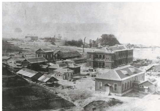
海軍病院(手前)と建設中の呉鎮守府(奥)
