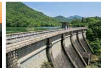
本庄水源の堰堤水道施設（昭和）
