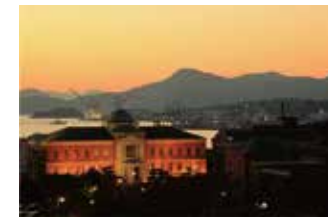
旧呉鎮守府庁舎（海自呉地方総監部第一庁舎）（中央）
