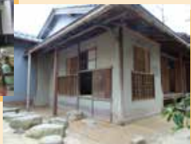
修理 (旧金子家住宅)
