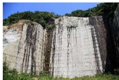
宮ノ浜採石場（倉橋）
