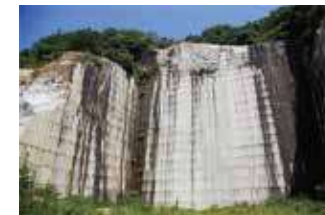
宮ノ浜採石場（倉橋）
