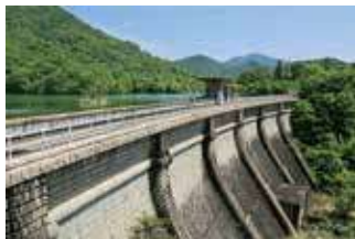
本庄水源地堰提水道施設(昭和)
