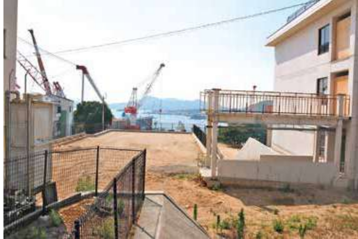
▲解体が完了した宮原小学校
