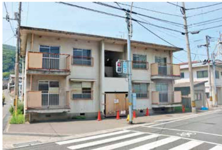
▲老朽化が進む川尻東第 5 住宅
