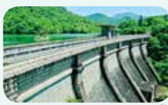
本庄水源地のえん堤
