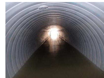
更生工事完了後の下水道管
