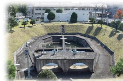
廃止した戸坂取水場
