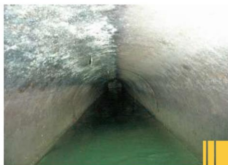
工事前の下水道管
