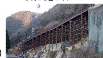
工事がすすむ呉平谷線
