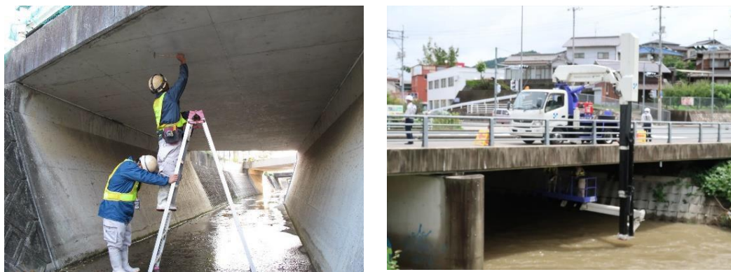
橋梁定期点検状況（※出典：呉市橋りょう長寿命化修繕計画）
