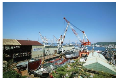
旧海軍工廠造船船渠大屋根（中央）
