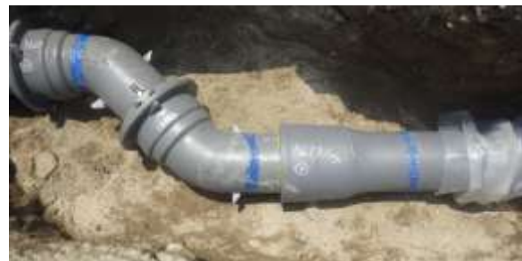
▲耐震管の布設状況（ダクタイル鋳鉄管）
