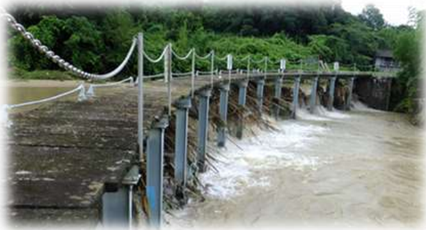
本庄水源地 取水口（水道）
