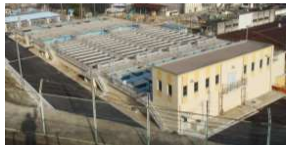
▲耐震化した宮原浄水場の浄水施設
