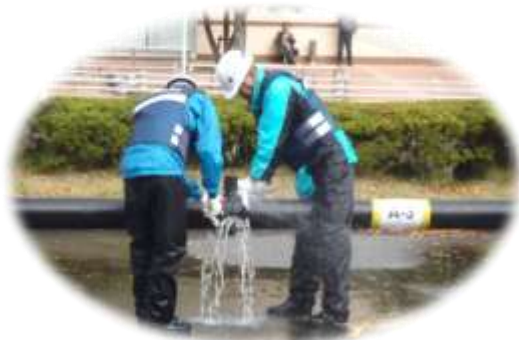
応急復旧訓練
