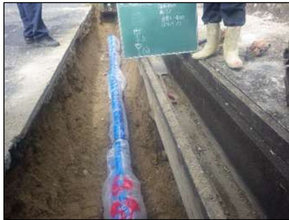
管路更新工事
