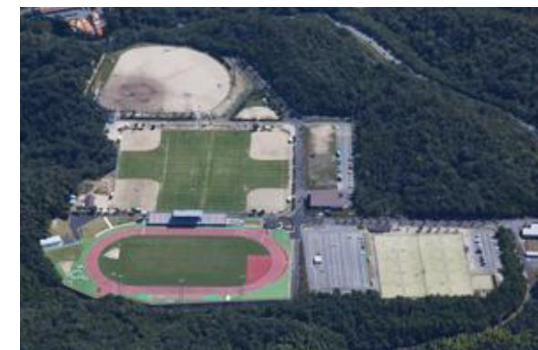
呉市総合スポーツセンター
