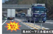
※東広島・呉自動車道と同様な道路にワイヤロープを設置し、対向車線への飛び出し事故が約95%減少
