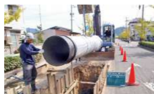
▲管路の耐震化の様子
