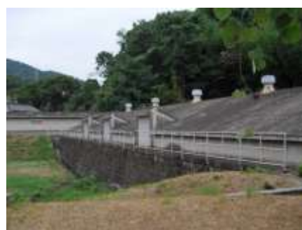
○鍋崎配水池（中央地区） 明治36年築造
