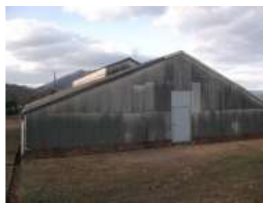
○名田山配水池（広島地区） 大正14年築造
