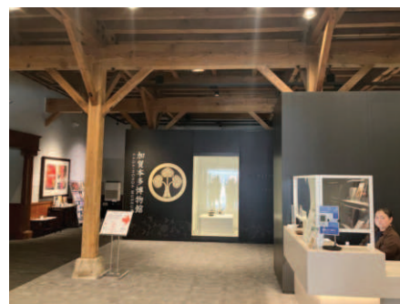
写真5. 第3棟は木造構造を残し、竣工当初の姿に最も近い
