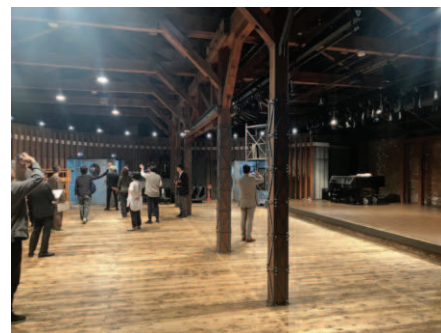
写真5. 既存のレンガ壁を活用したスタジオ
