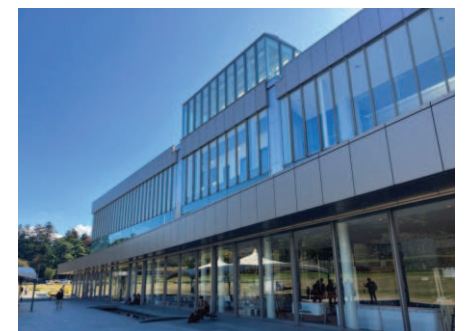
写真2. 施設外観（改修部）
