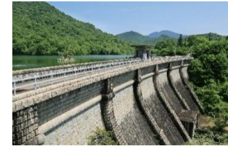
本庄水源地堰堤（昭和）
