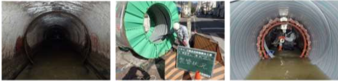
工事前の下水道管
