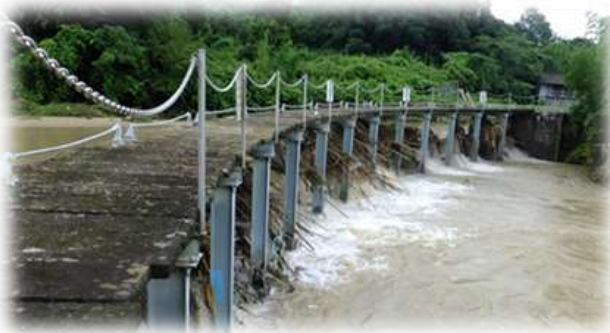
本庄水源地 取水口（水道）
