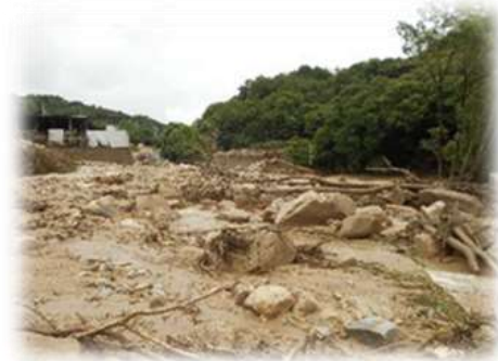
柳迫第 1 ポンプ所（水道）
