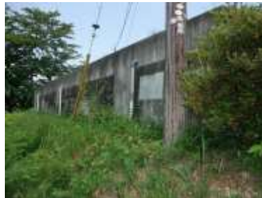
新城平配水池（音戸地区） 昭和 43 年築造
