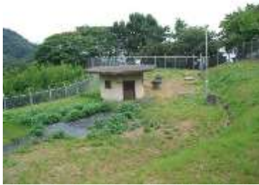
冠崎配水池（阿賀地区） 昭和 36 年築造
