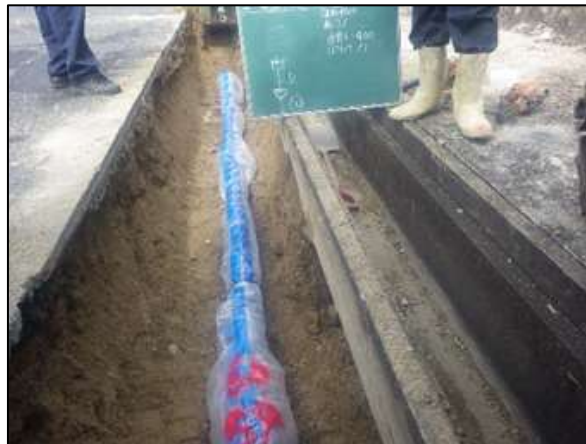
管路更新工事
