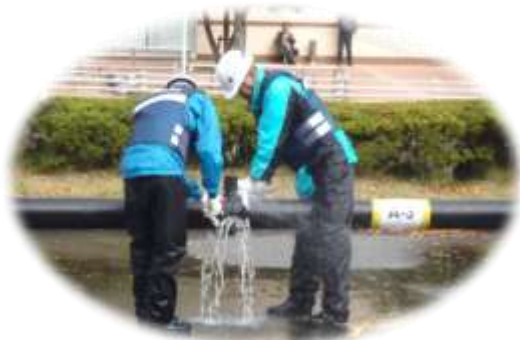
応急復旧訓練
