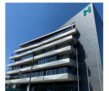
ホーコス本社ビル(福山市)
