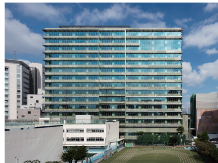
渋谷区役所庁舎の電気設備工事
